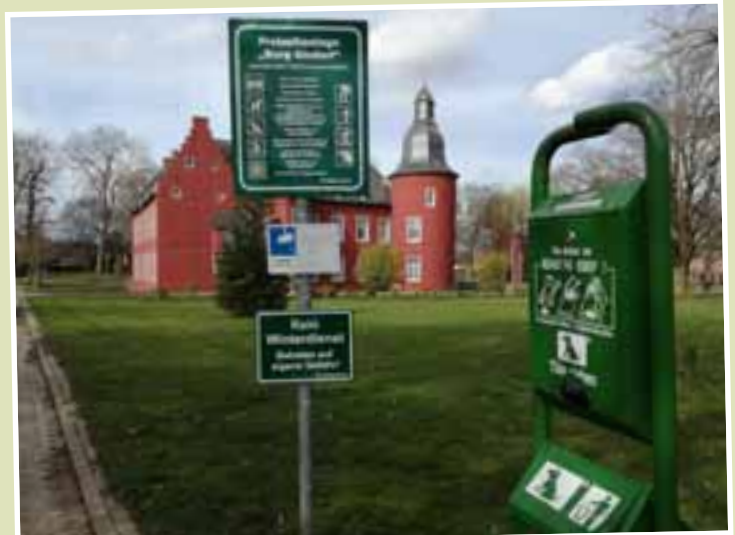
Teure und von Vandalismus heimgesuchte Dog-Stationen wie im Park der Alsdorfer Burg gibt es nur noch wenige
